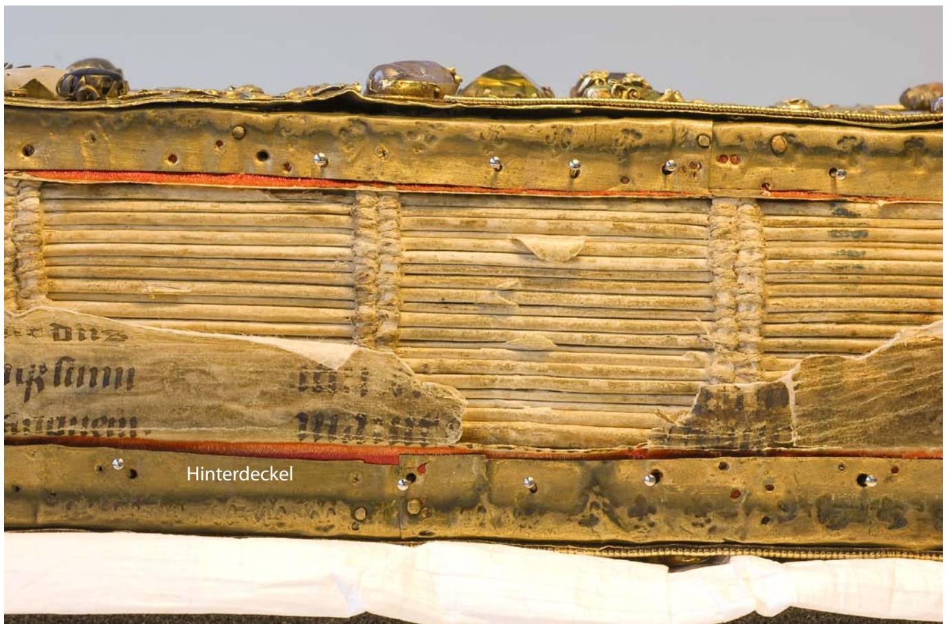
in Arbeit mittleres Rückendrittel: Rücken nach dem ablösen der Zierleisten, als Platzhalter wurden silbrig glänzende Nägel eingesteckt
