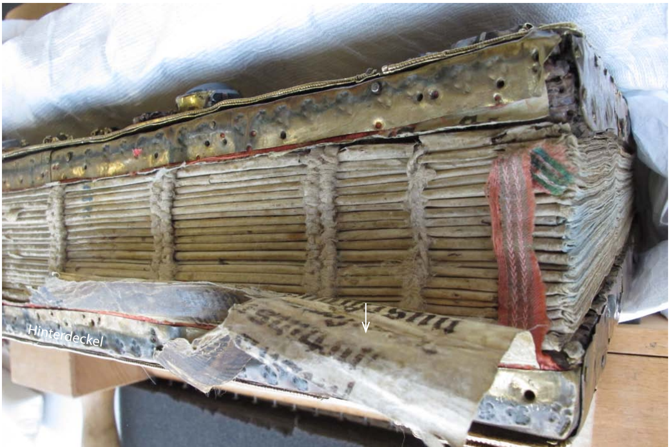
in Arbeit: Japanpapier der Notsicherung von Rückeneinlage abgelöst (weisser Pfeil), beim roten Gewebestreifen handelt es sich um den Einschlag des Bezugewebes
