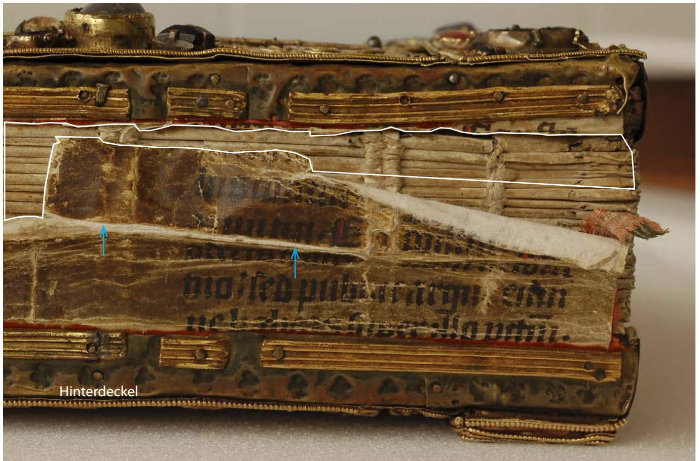
vorher unterstes Rückendrittel: Rücken mit Fehlstellen (innerhalb der weissen Linie) und Rissen (blaue Pfeile) in der Rückeneinlage (Pergament)
