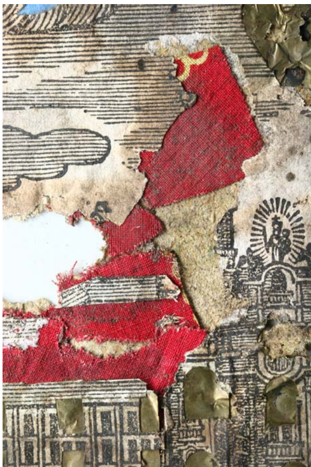
vorher : Fehlstelle links, lose Metallfolien
